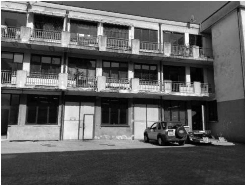
Foto 4 – Prospetto edificio interno al cortile comune
