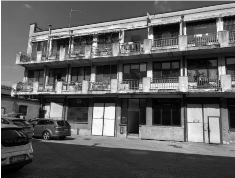
Foto 5 – prospetto edificio interno al cortile comune
