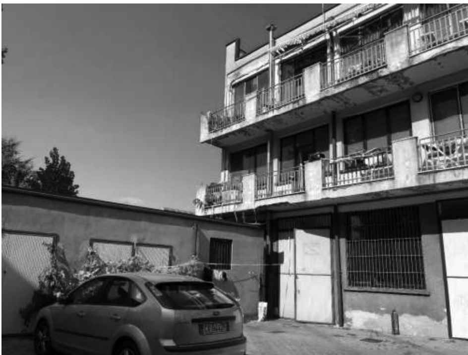
Foto 6 – Sulla destra Ingresso laboratorio pignorato, sulla sinistra deposito pignorato
